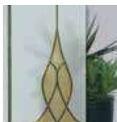
Vetro tipo cattedrale con elementi colorati e inserzioni di piombo. VO/VZ
